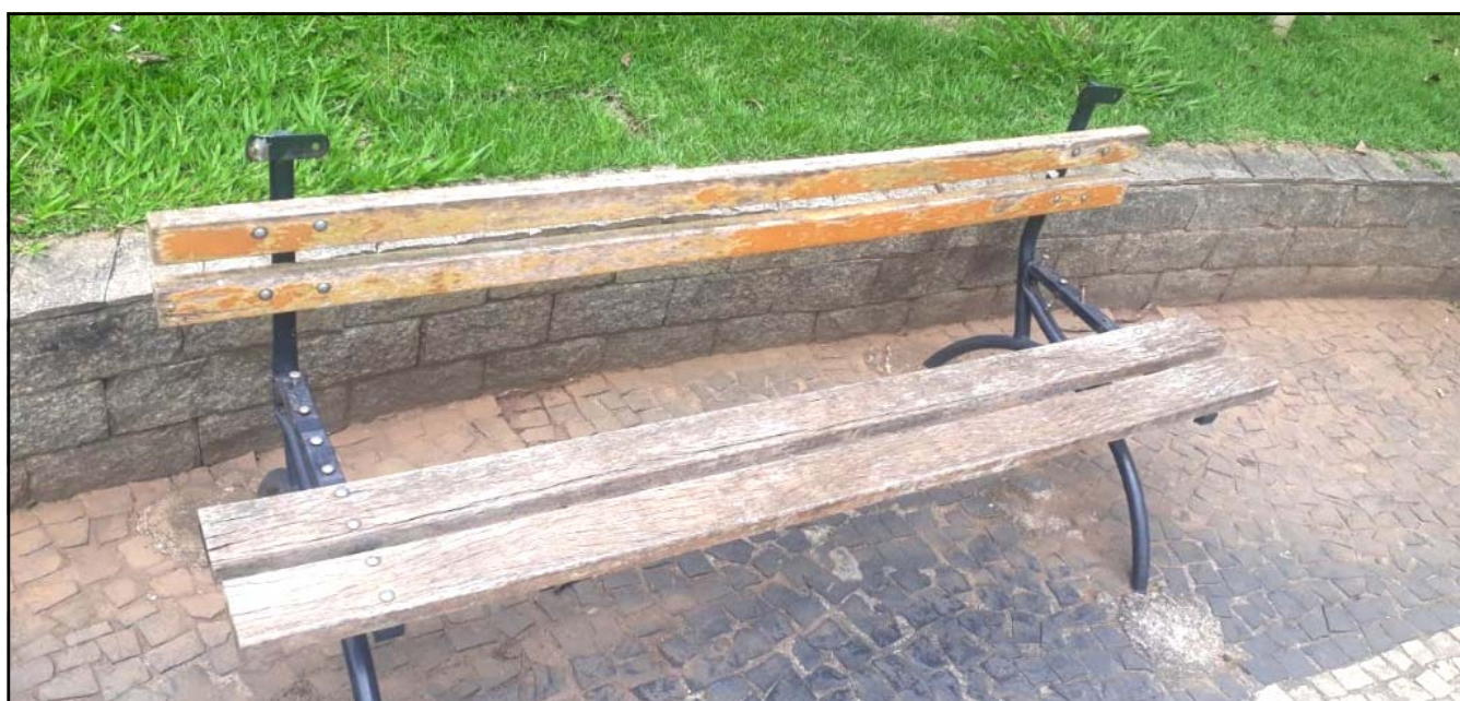
Banco na Praça Senador José Beto - faltam ripas - falta manutenção
